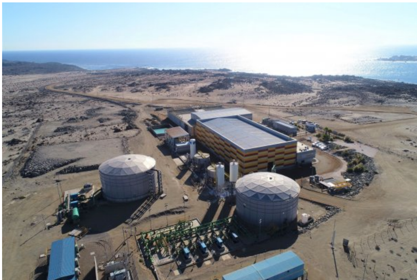
Planta desaladora multipropósito de CAP
