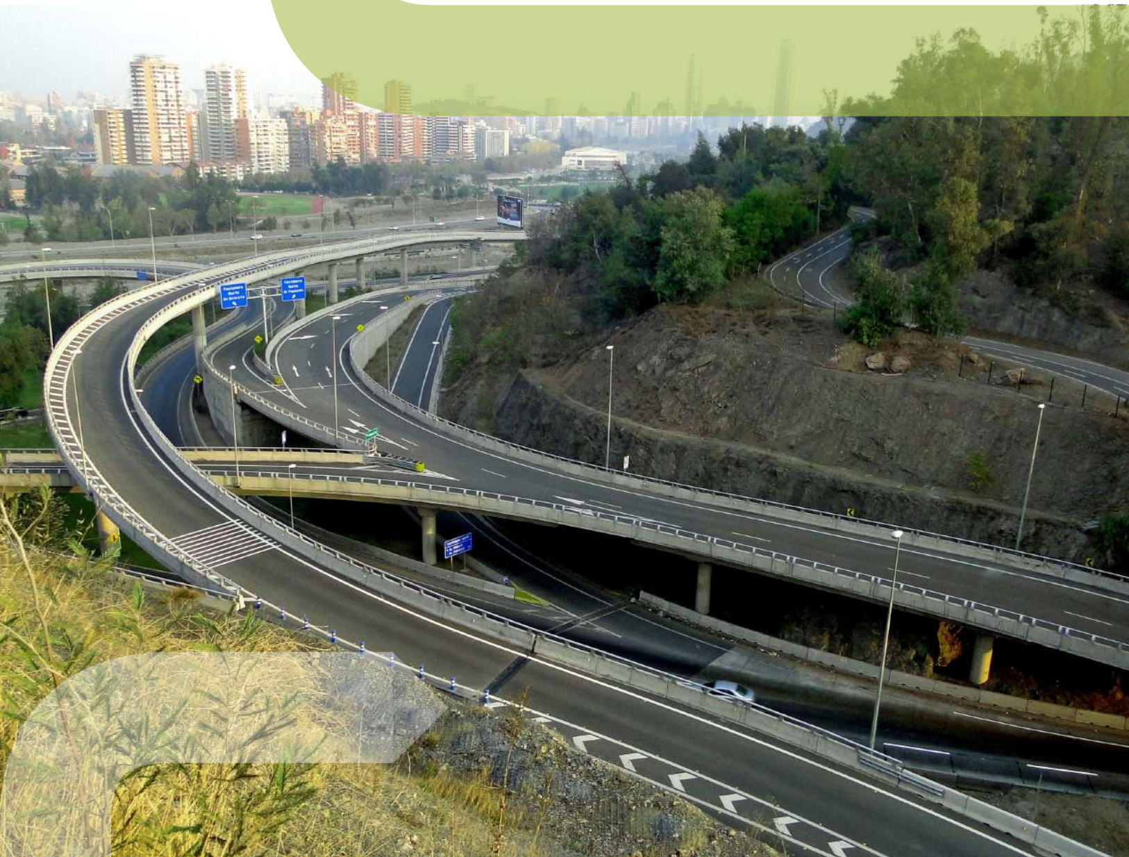
ENLACE CENTENARIO Fotografía gentileza RCQ Ingeniería.
