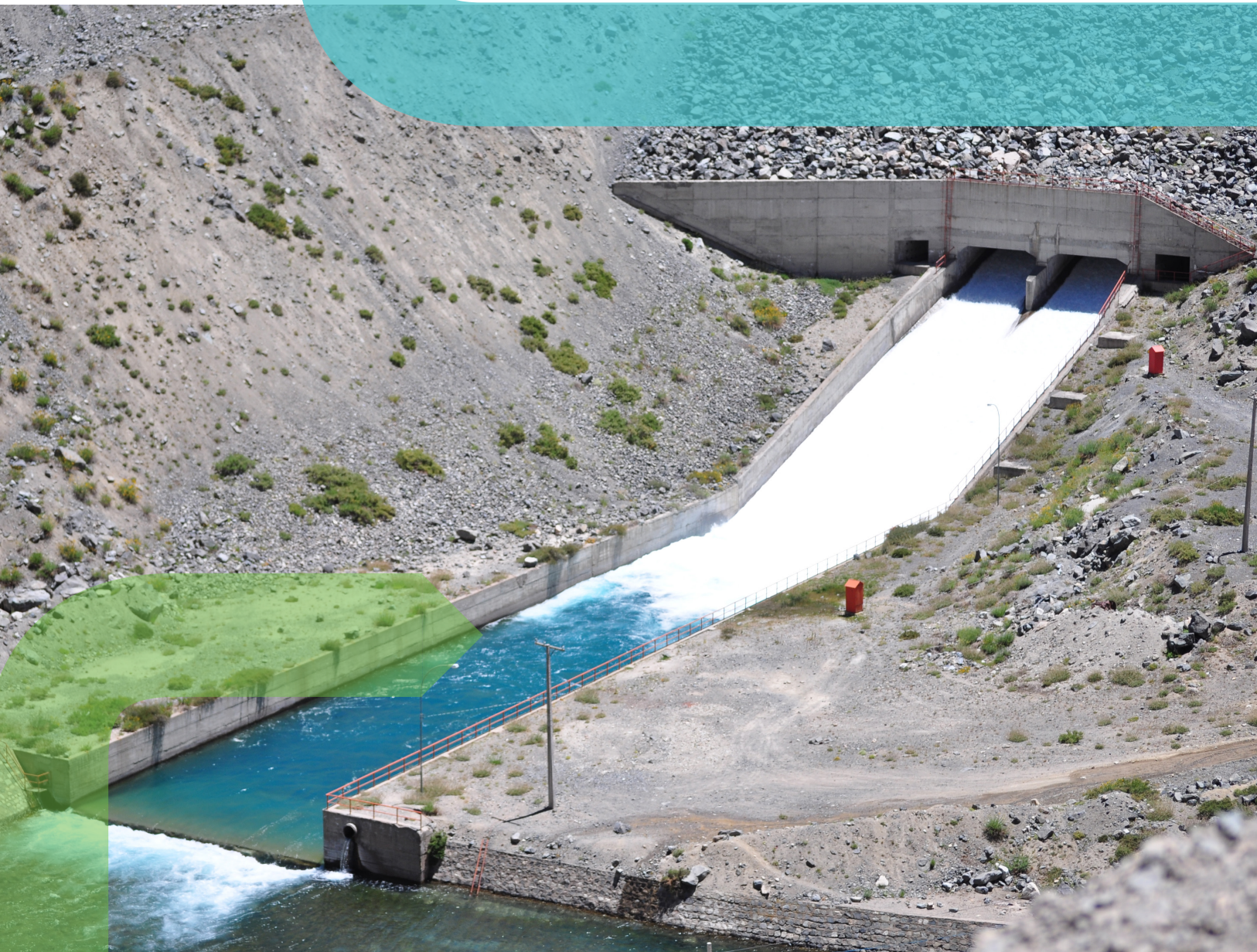
EL YESO RESERVOIR
